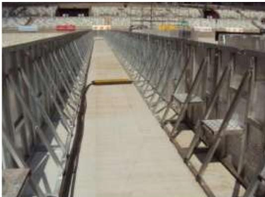
**Figura H.5 a:** Modelo de barreira antiesmagamento com plataformas de apoio
