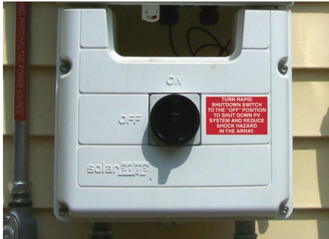
Figura 9: Exemplo de dispositivo de desligamento rápido Fonte: Article 690 Solar Photovoltaic (PV) Systems – NFPA 70
